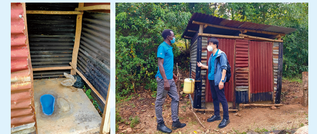
プロジェクトに地域住民が参加することで、新しいトイレ建設がより一層進んでいます。
