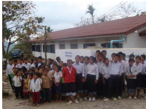
雨水タンクなどの給水設備が必要です
