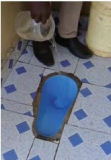
住民が建設したトイレ 株式会社LIXILのSATO PANを使用
