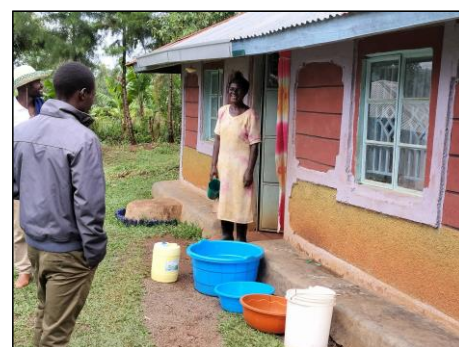
(雨樋の改善により集水効果が向上)
